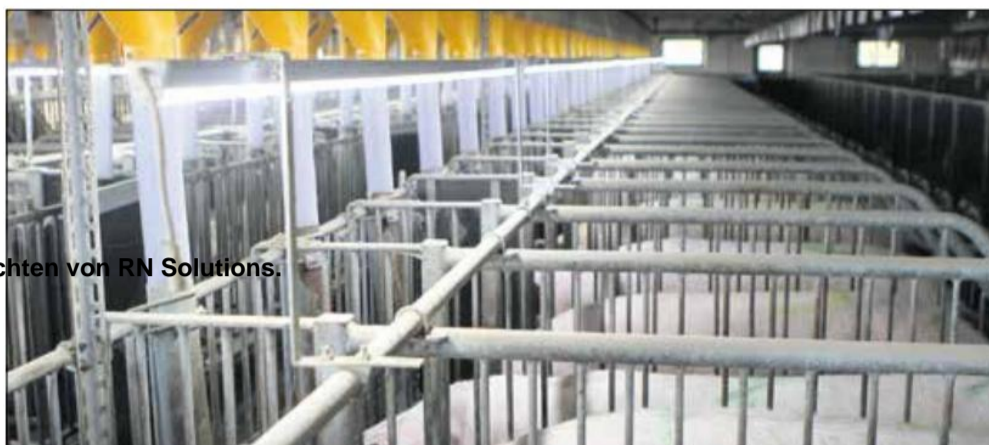
Mittlerweile haben auch die Amerikaner ihre Augen für dänische LED-Leuchten geöffnet. Es ist RN Solutions aus Nordjütland, das die Anerkennung der World Pork Expo für seinen positiven Einfluss auf die Effizienz der Schweine sowie für seine Langlebigkeit und seine einfache und erschwingliche Lösung erhalten hat. (Foto: Anne Wolfenberg)
